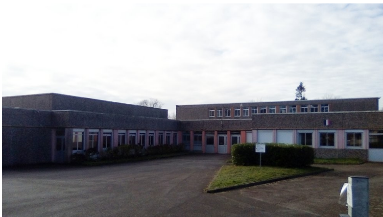
Le bâtiment actuel du collège Édouard Herriot
