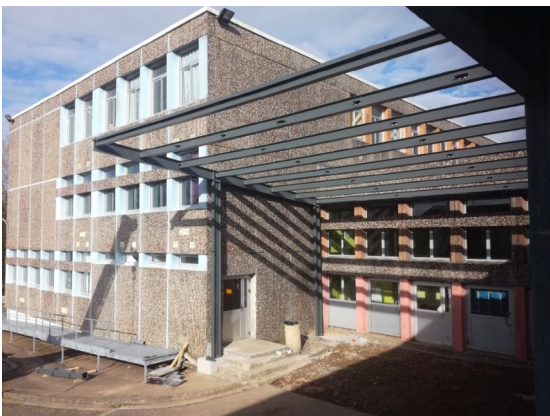
Le préau en cours de construction
